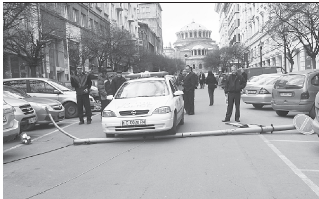
Електрически стълб падна на ул. "Съборна" в центъра на столицата вчера. Стълбът бе паднал напречно на улицата до паркиралите коли в синята зона. По чудо нямаше пострадали хора и щети по автомобилите
