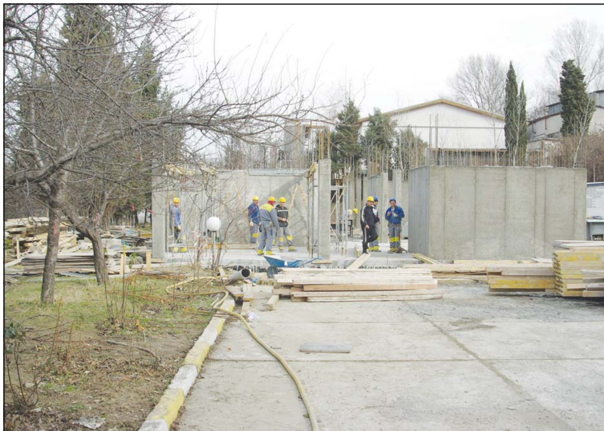
Строителството на ново РПУ в кв. "Стумско" на Благоевград върви с пълна сила. Първата копка беше направена на 9 януари т.г.
