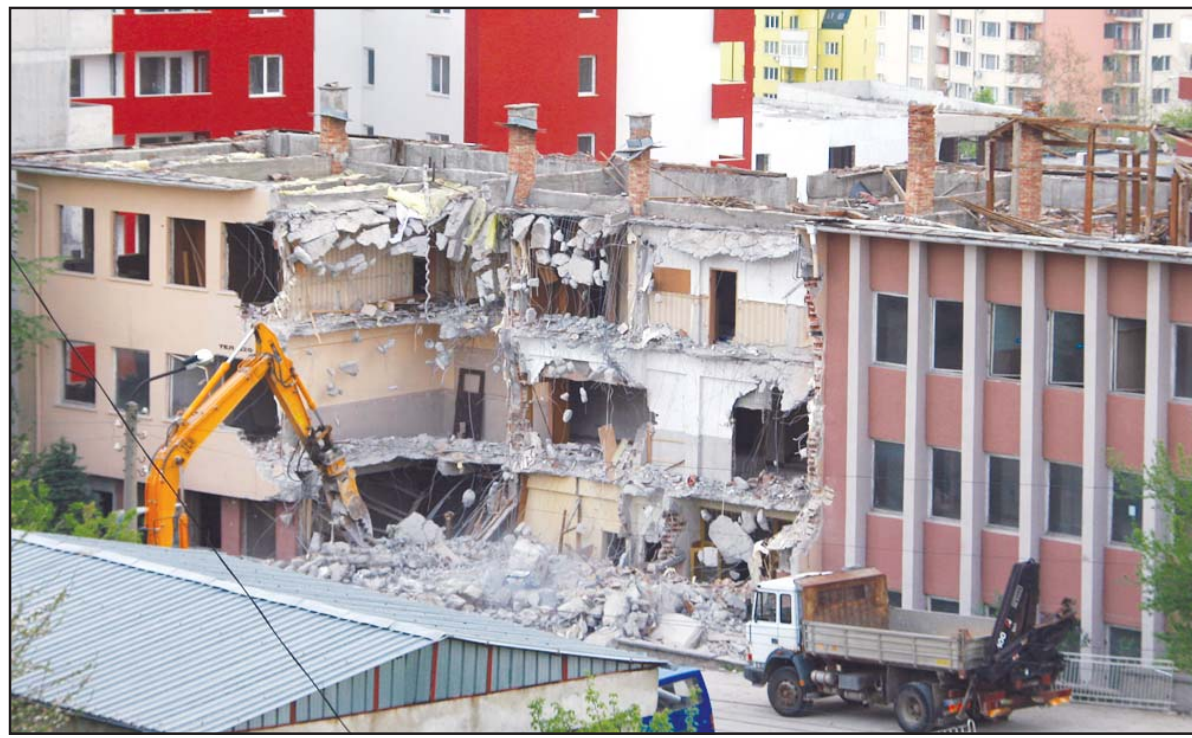
Във Велико Търново започна разрушаването на стара триетажна сграда. На нейното място ще бъде издигнат жилищен блок, част от новостроящия се комплекс "Слънчев дом"
