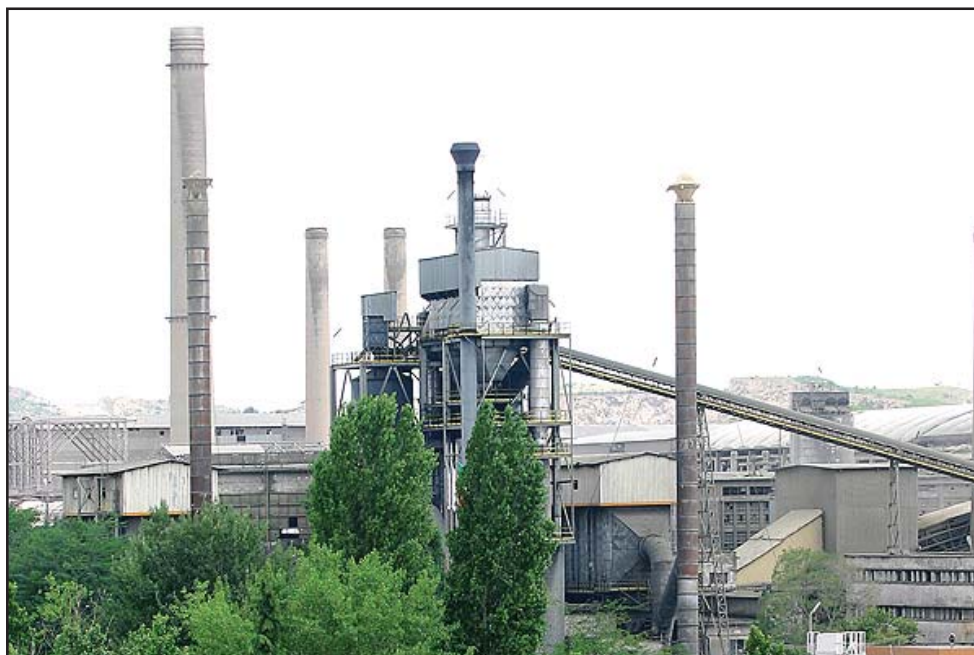
"Девня цимент" у нас спря производствените линии за ремонт по-рано от предвиденото, а част от работниците бяха пуснати в отпуск. Кризата ще забави реализацията с 10 до 14 месеца изграждането на нов завод
