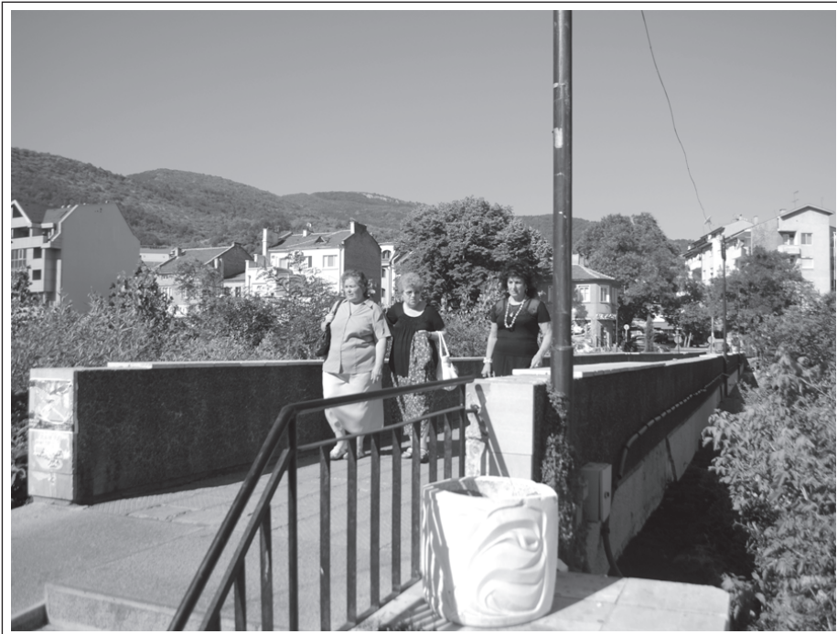
В Асеновград днес затварят за движение пешеходния мост на ул. "Кап. Петко Войвода" над р. Чая. Мостът ще бъде "бутнат" изцяло и на негово място ще се изгради ново съоръжение. До момента е преместена оптичната линия, спряна е газта по тръбата, а ВиК го сряда ще отстранят и водопровода, съобщиха от общината. Тръбата, която захранва с питейна вода кв. "Запад", ще пресече реката по гъното на коритото ѝ
