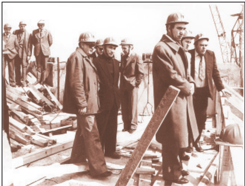
На строежа на НДК, 1978 г.
