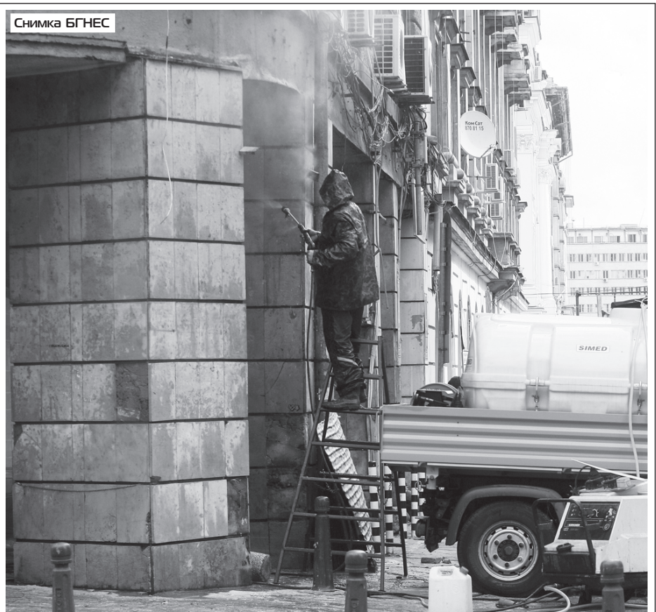
Работници старателно ремонтират тротоарите и почистват сградите на ул. "Граф Игнатиев" в чест на предстоящото посещение на италианския премиер Силвио Берлускони
