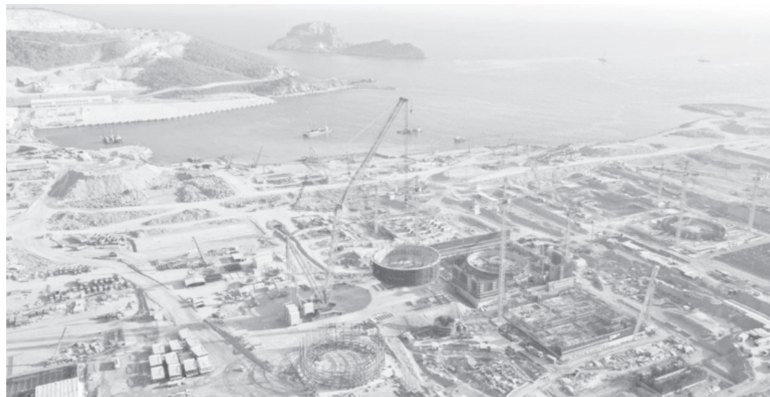
Внушителната строителна площадка на АЕЦ „Аккую“
