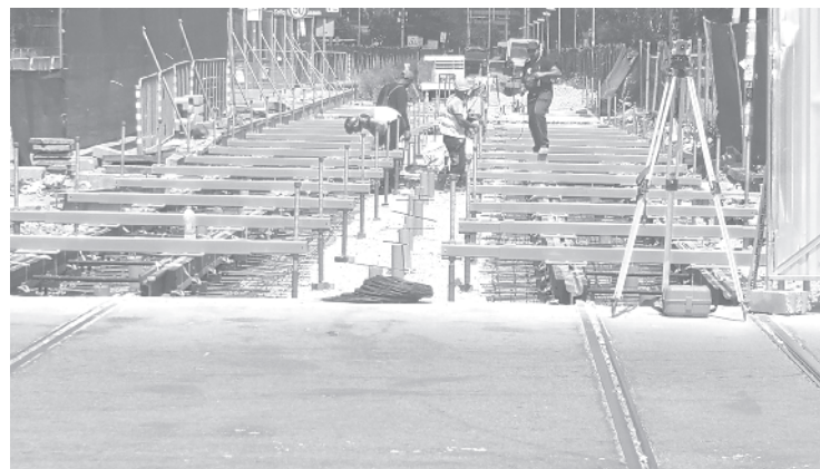
Ремонтите на “Цар Борис III”
