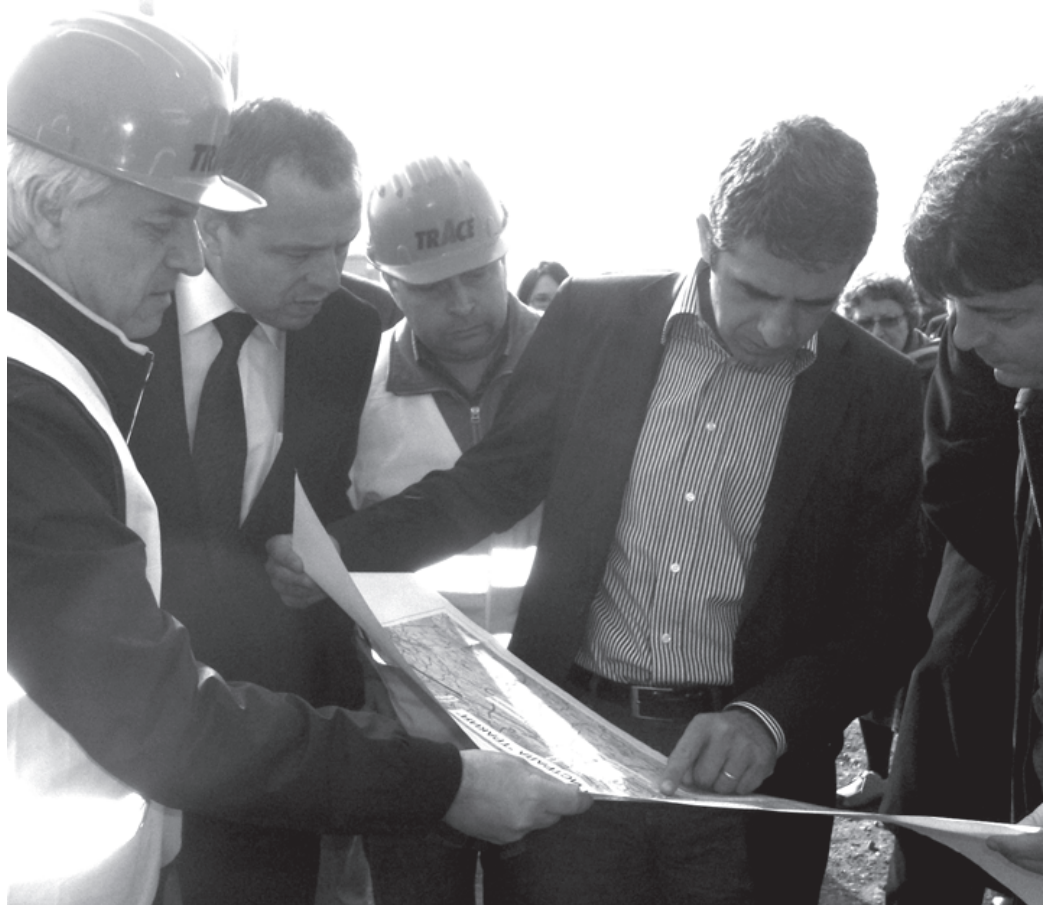
Министър Плевнелиев направи вчера проверка на строителството на АМ "Тракия"
