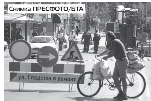
В Пловдив започнаха големите летни ремонти. До края на лятото ще бъдат основно ремонтирани главните булеварди и централните улици на града
